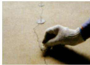
注入治具取付
