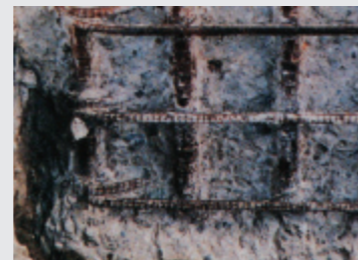
はつり後の腐食確認状況(地表面付近)
