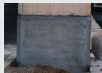
断面修復材の施工
